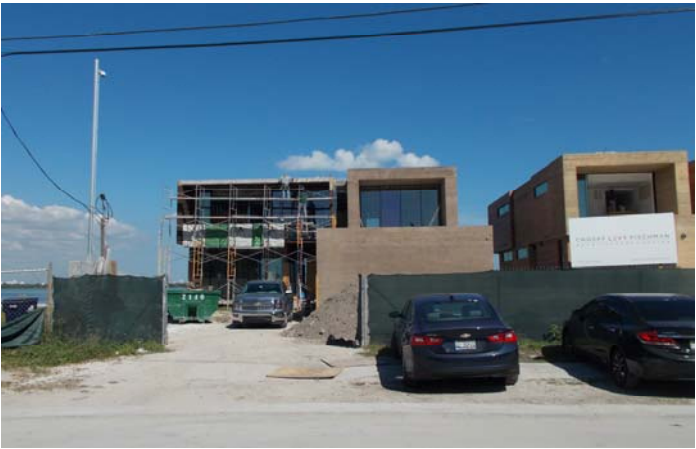
X 835 E DI LIDO DRIVE UNDER CONSTRUCTION
