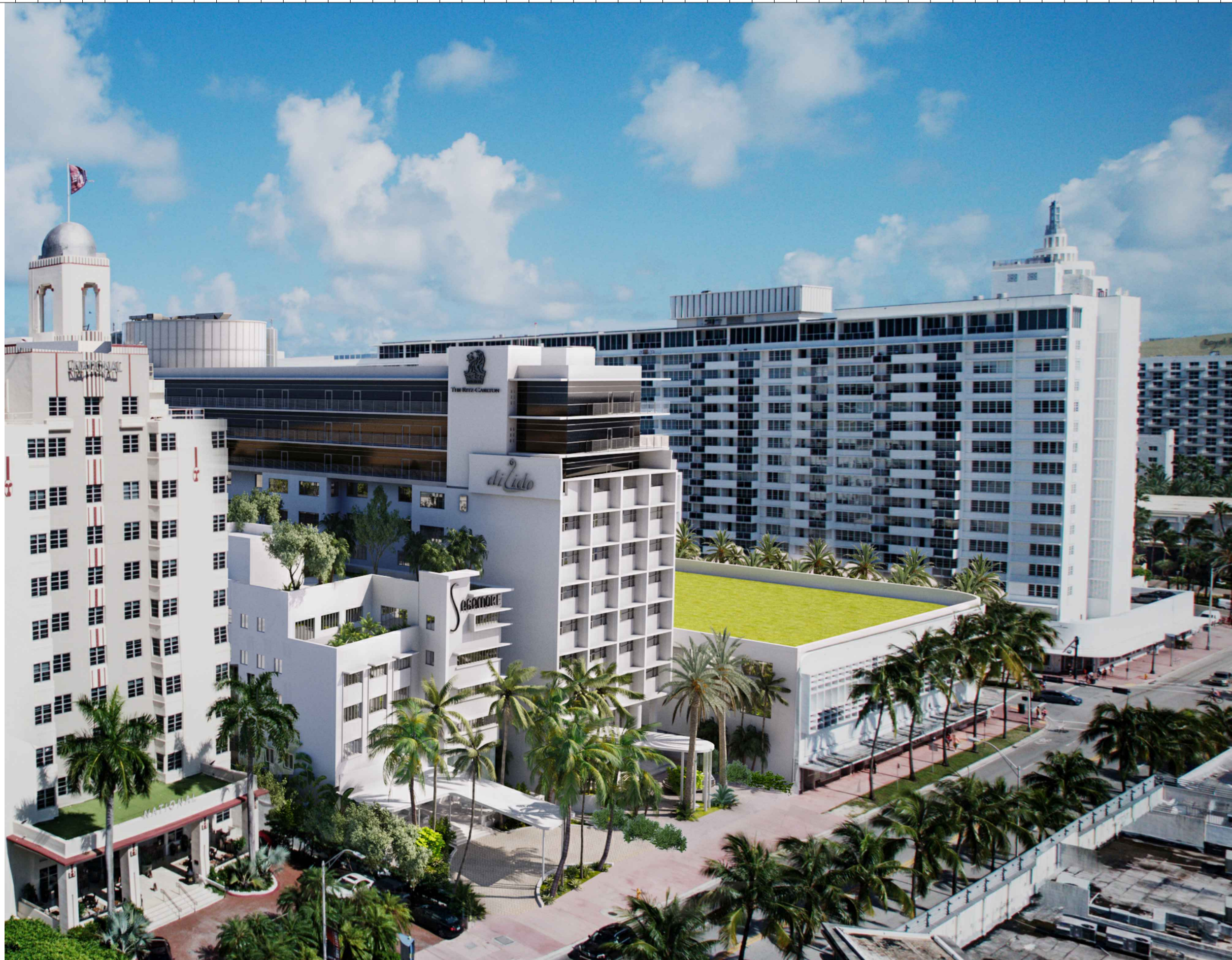
○ AERIAL VIEW FROM COLLINS AV
