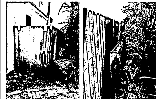
(D) EXTERIOR FENCE VIEW
