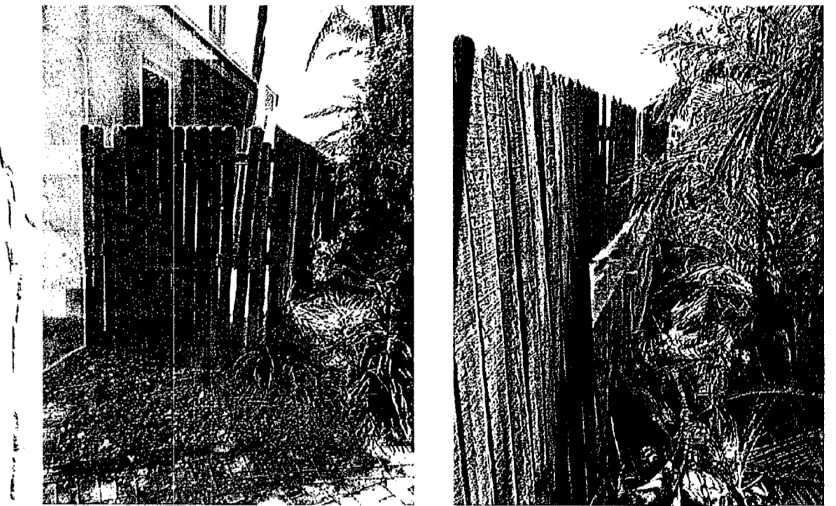
(D) EXTERIOR FENCE VIEW
