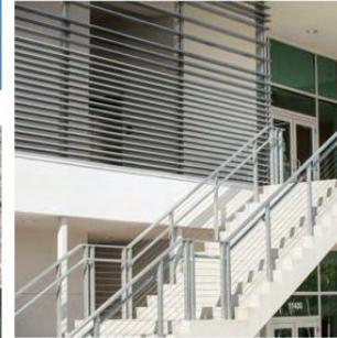
ALUMINUM HORIZONTAL SCREEN FOR STAIR ENCLOSURE
