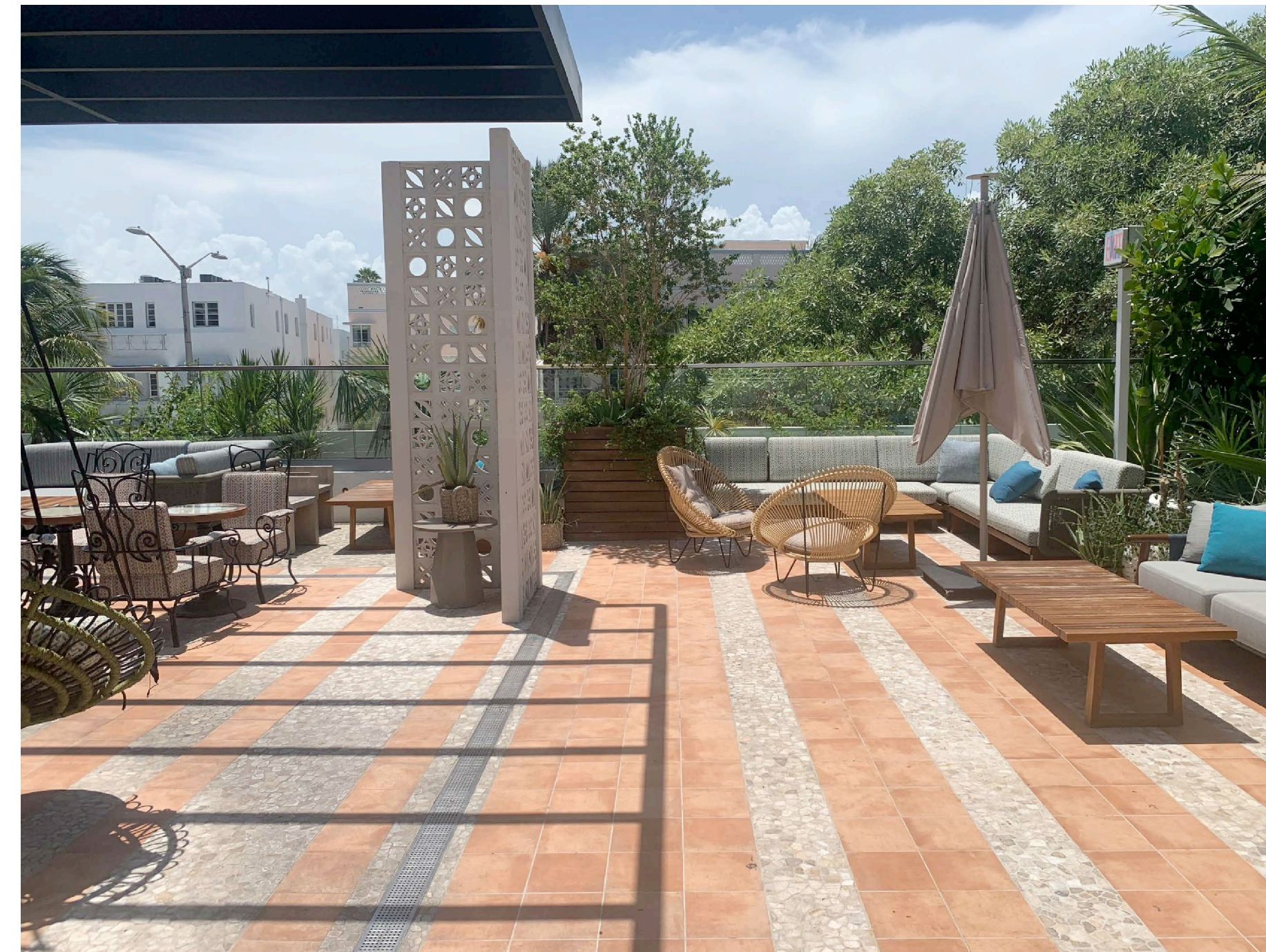
5 PHOTO EXISTING CONDITIONS SCALE: N.T.S.
