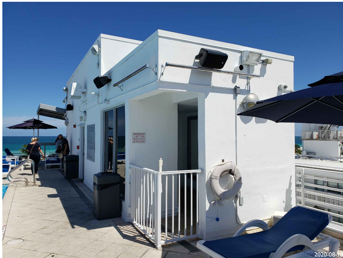
2020-08-18 27. ELEVATOR LOBBY ENTRANCE
