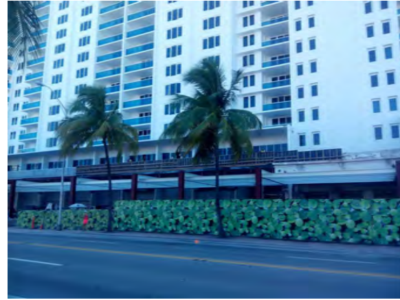
2 COLLINS AVE: LOOKING NE (04/14/14) SCALE: N.T.S.
