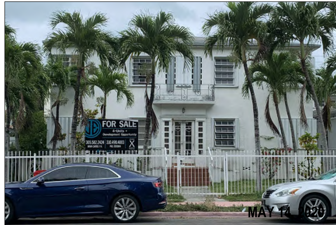
635 LENOX AVE (SUBJECT PROPERTY)
