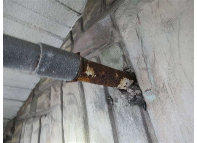
CORRODED CONDUIT
