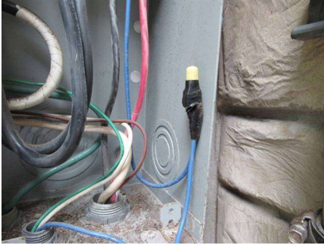
LOOSE WIRING
