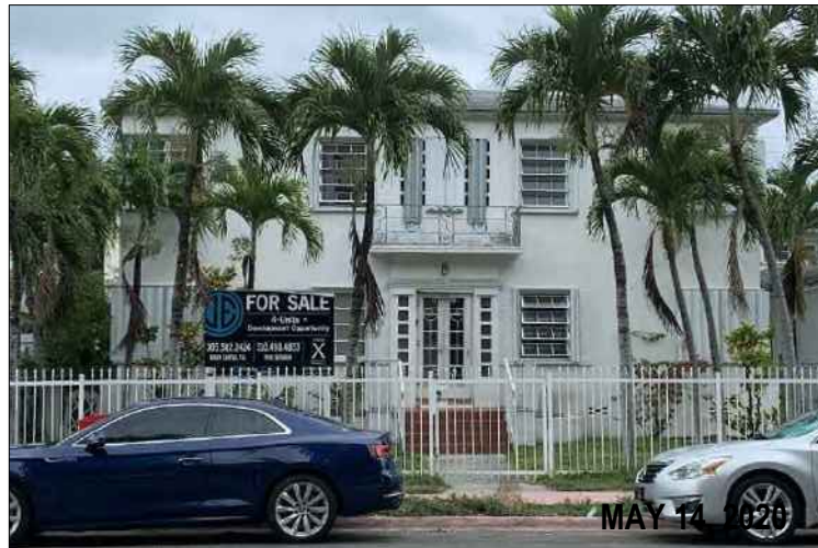
635 LENOX AVE (SUBJECT PROPERTY)
