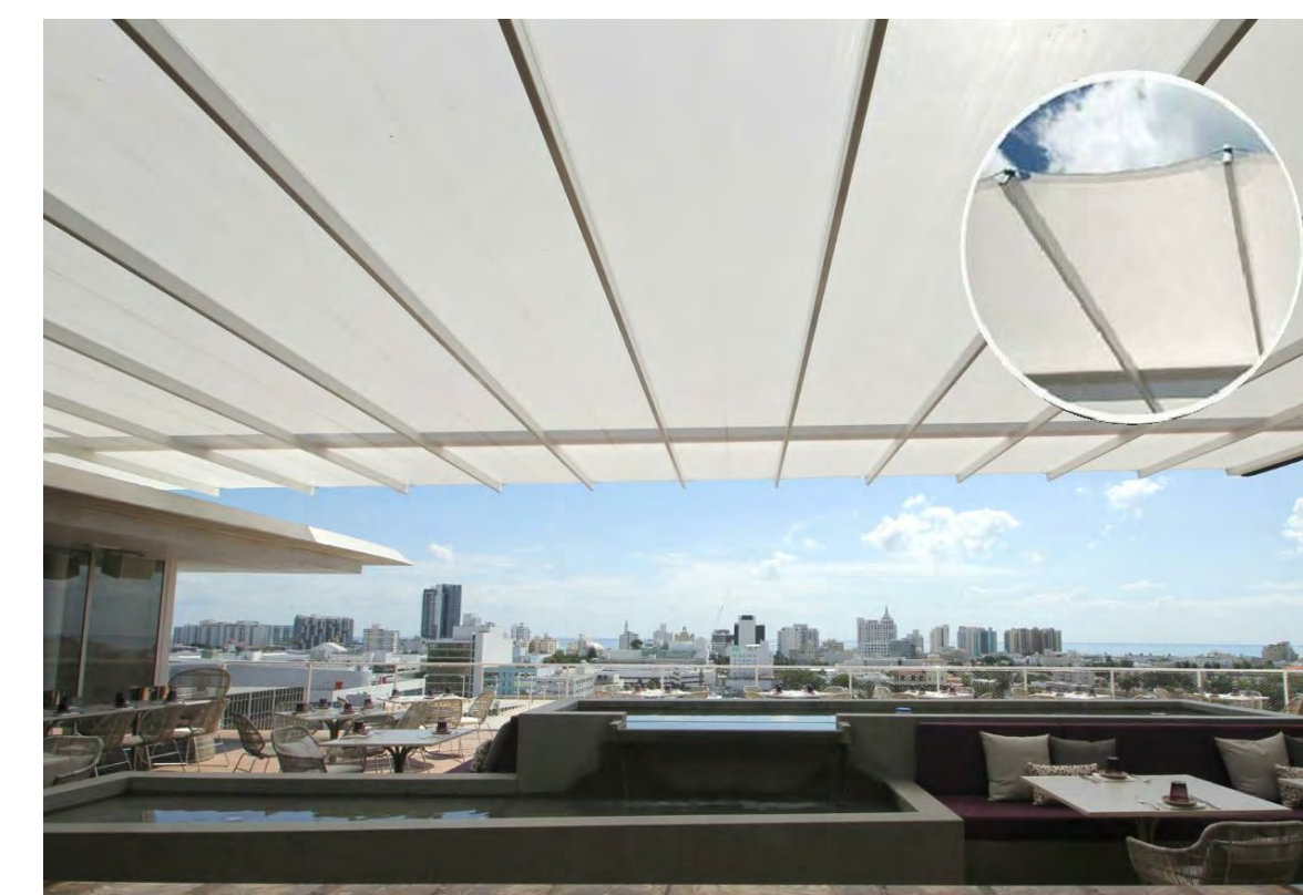
TRUE TENSILE MEMBRANE STRUCTURE
