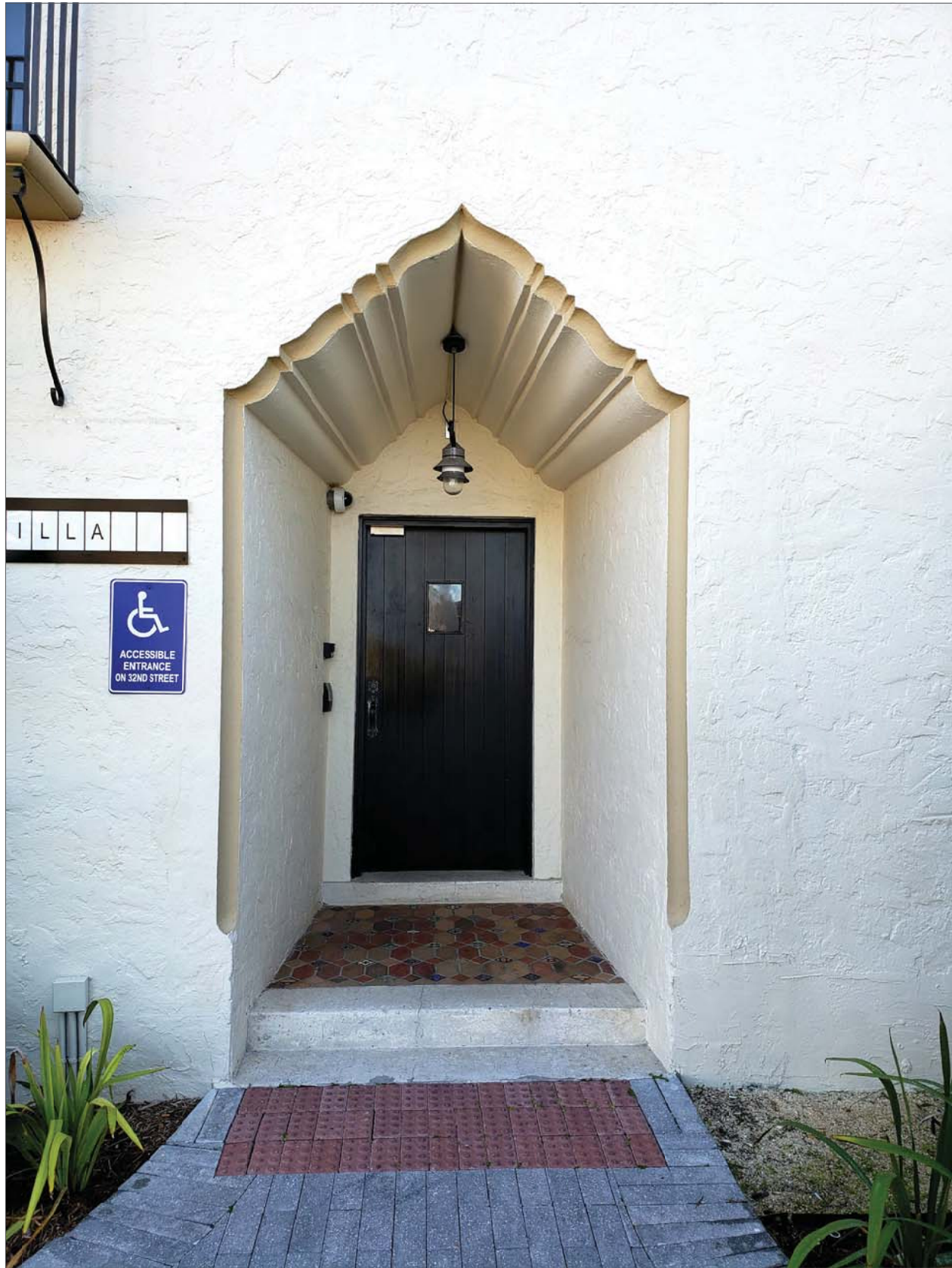
1 BUILDING A: ENTRY VESTIBULE SCALE: N.T.S.
