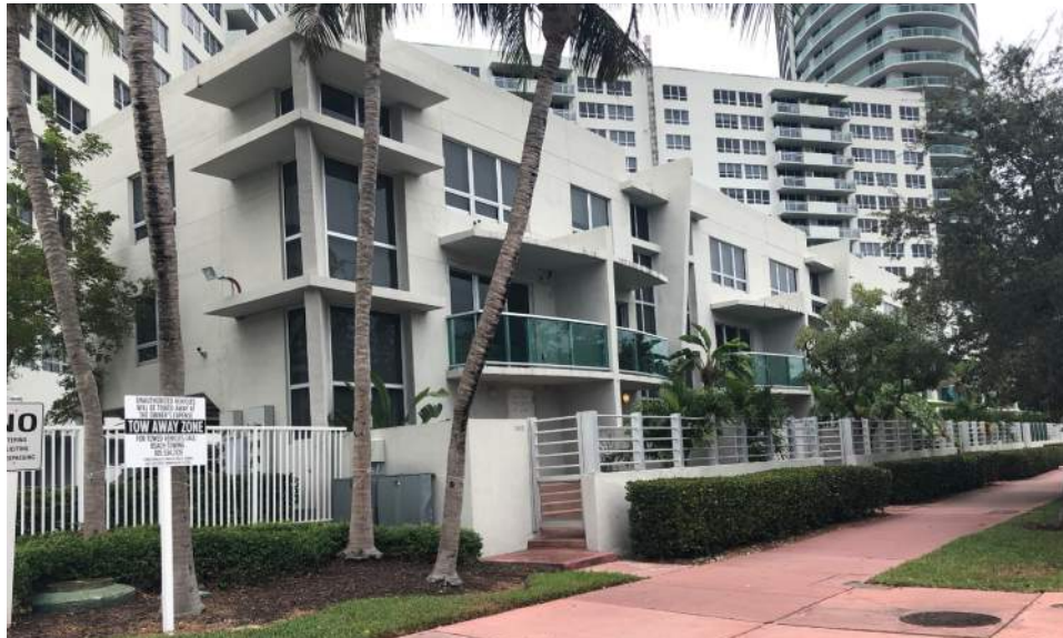
A1 1422 / 1424 / 1426 / 1428 / 1430 / 1434 / 1436 / 1504 / 1536 BAY ROAD BAY ROAD
