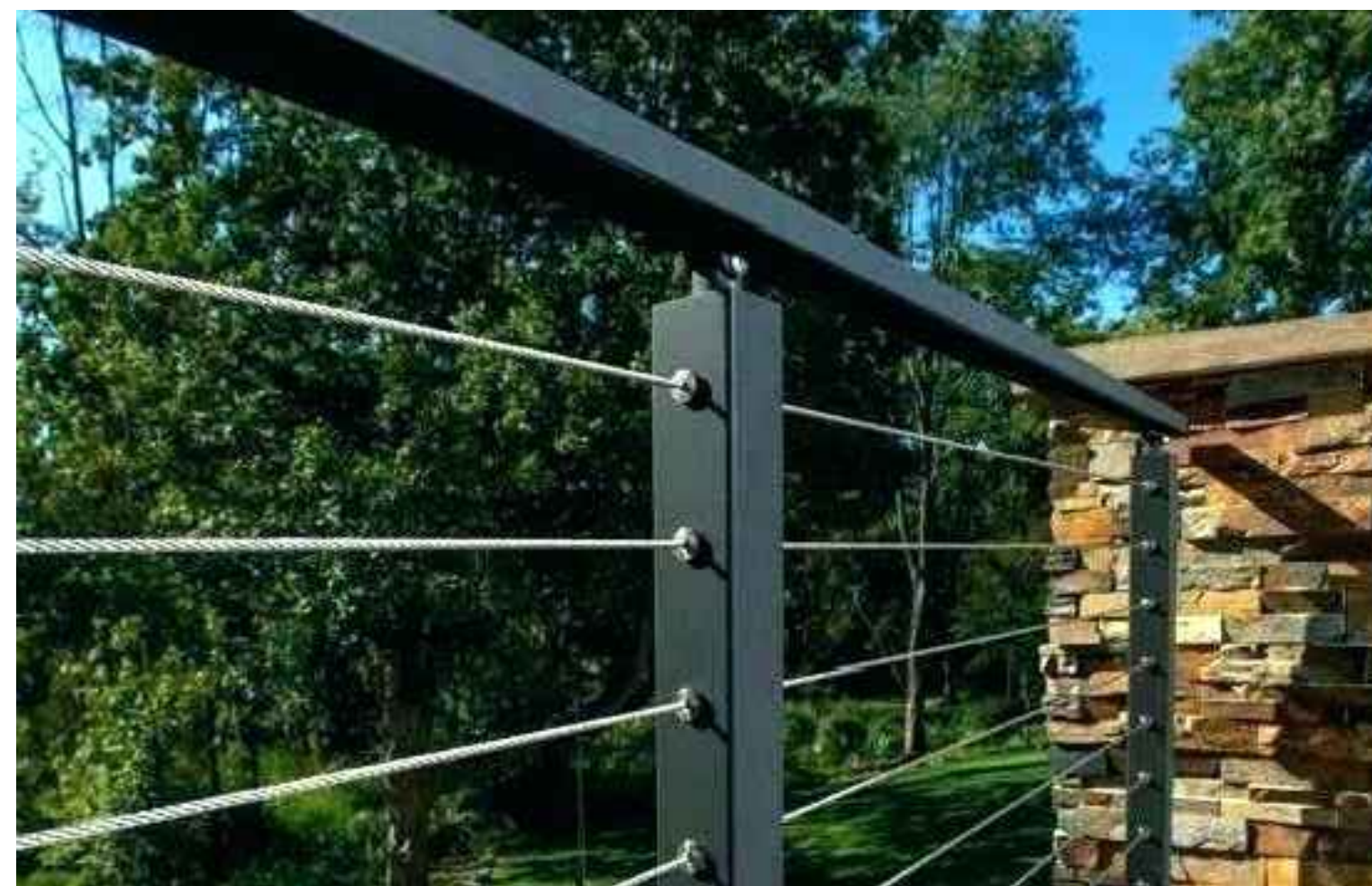
CABLE RAILING 42" A.F.F.
