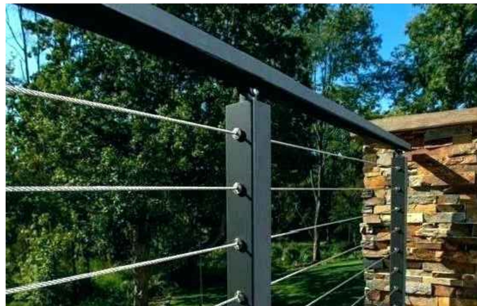
CABLE RAILING 42" A.F.F.
